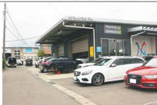
手前が整備棟で奥が钣金塗装棟
